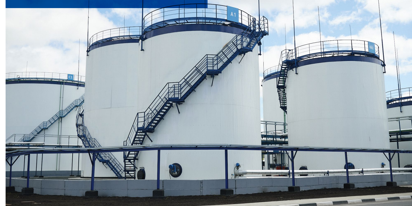
Битумный терминал, г. Екатеринбург. Резервуары интенсивного нагрева ErichHahn HT
